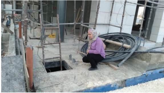
فتحة بئر لتجميع مياه الأمطار في مبنى سكني قيد الإنشاء - منطقة عبدون
